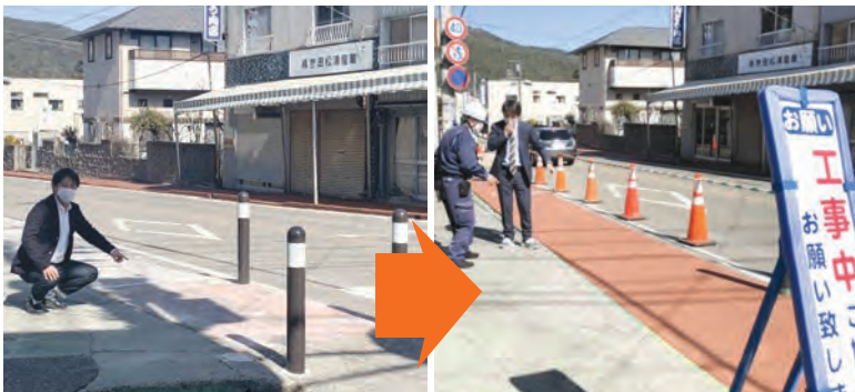
本町通り活性化のため継続的に歩道を整備しています。
